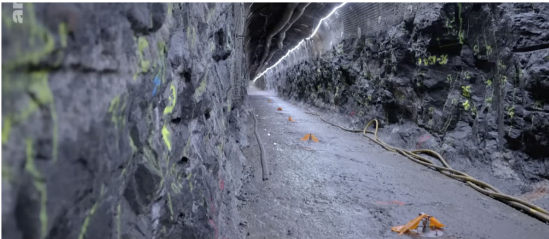
Im finnischen Endlager für hochradioaktiven AKW-Abfall sind 50 Kilometer solcher Tunnel im Bau, unter denen die Müll-Fässer in dicken und wasserdichten Behältern versenkt werden. © Arte
